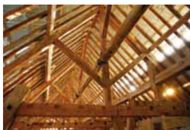
Charpente du pont-écluse Saint Amand
