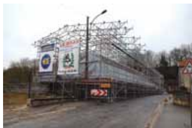
Pont-écluse de l'extérieur
