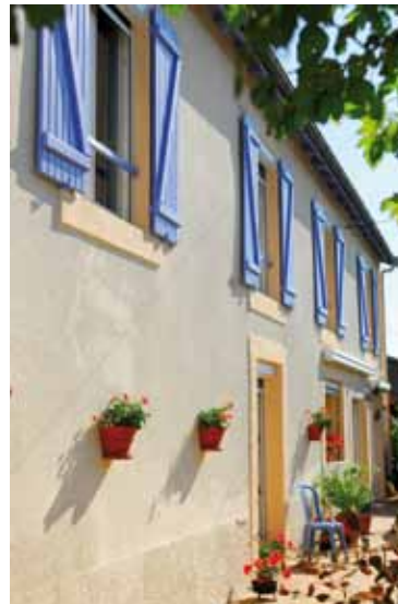
Ravalement de façade à Thierville
