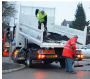
Rebouchage des trous
