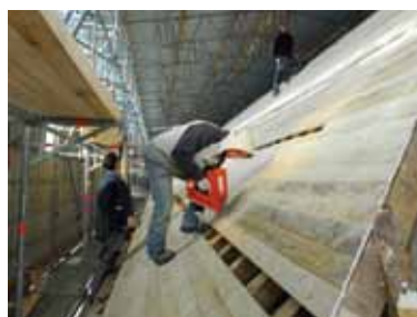
Pose de la volige
