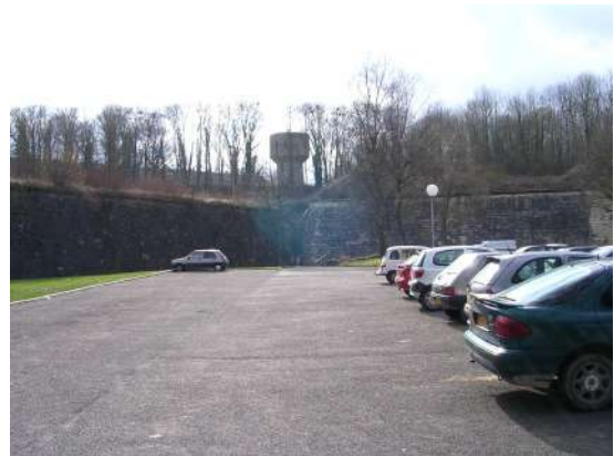
Vue du château d'eau, depuis la rue Pierre Demathieu
