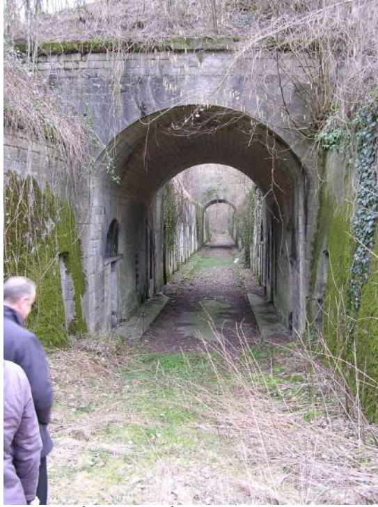
Tunnel à proximité du bastion du Dauphin
