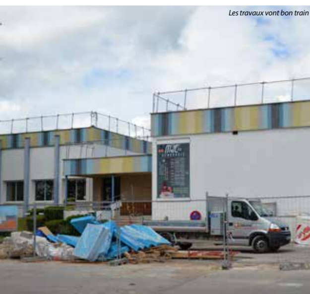
Les travaux vont bon train
