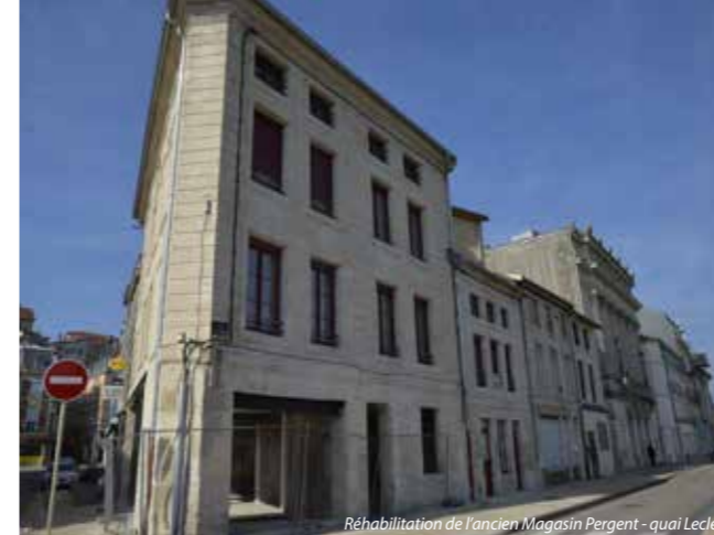
Réhabilitation de l'ancien Magasin Pergent - quai Leclerc
