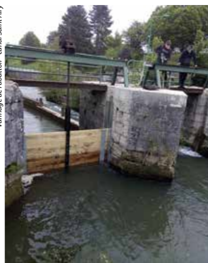
Vannage de l'abattoir - canal Saint Airy
