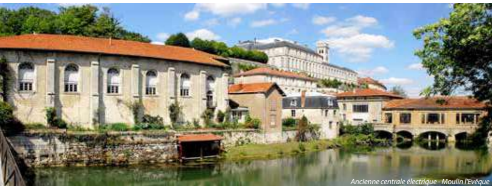
Ancienne centrale électrique - Moulin l'Evêque
