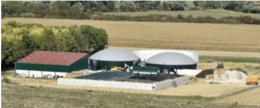
Usine de méthanisation situé à Varennes, Thierville-sur-Meuse (Source : Est-Républicain)
