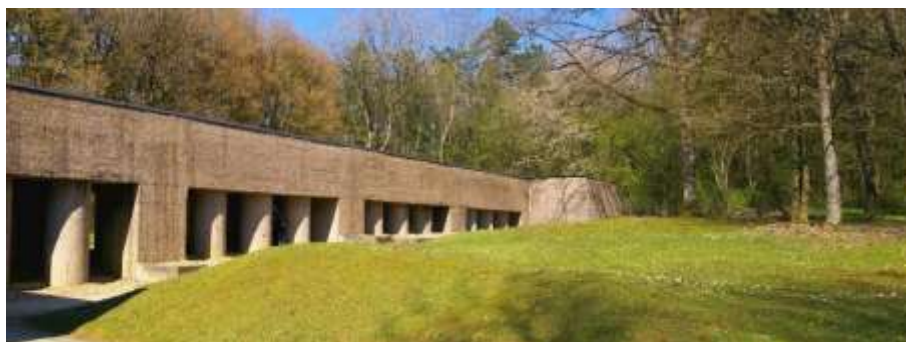
Figure 22 : Tranché des Baïonnettes – Douaumont-Vaux
