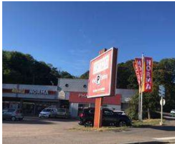
Enseignes scellées au sol supérieures à 1 m 2 en surnombre. Elles sont limitées à un dispositif par voie bordant l'établissement (article R. 581-60 du Code de l'environnement)
