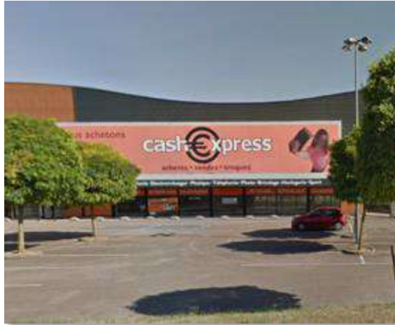
Surface cumulée d'enseignes trop importante (article R. 581.3 du Code de l'environnement)
