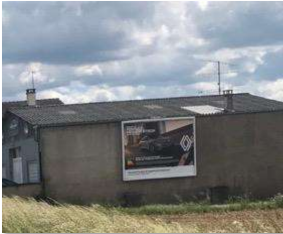
Surface > à 4 m 2 - Bras-sur-Meuse
