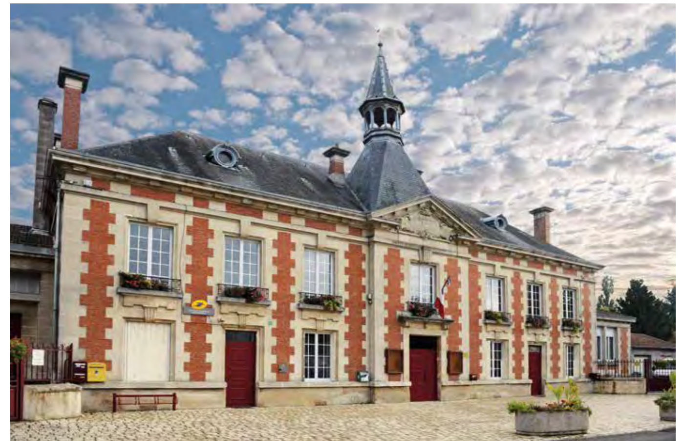
MAIRIE-ÉCOLE DE CHARNY-SUR-MEUSE. CONSTRUITE DANS LES ANNÉES 1920 PAR L’ARCHITECTE COULON
