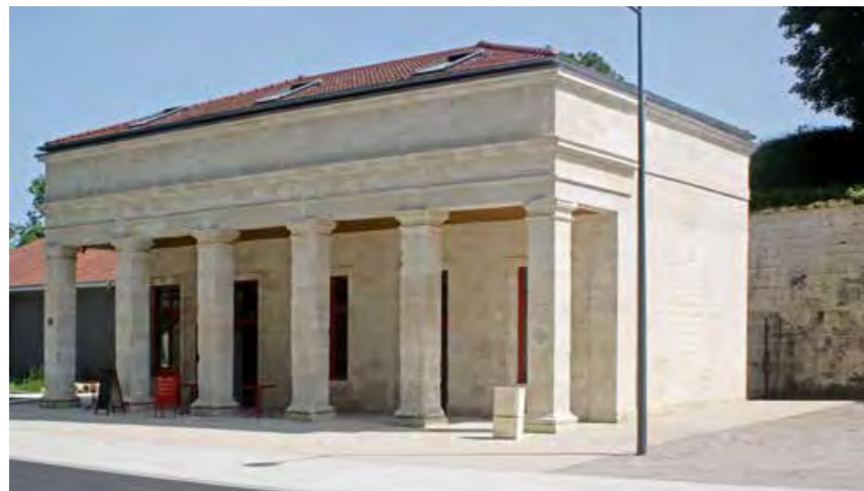
LE POSTE DE GARDE
